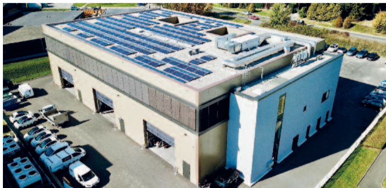
576 m 2 de panneaux photovoltaïques ont été posés sur le toit de la manufacture AAV à Plan-Les-Ouates.
