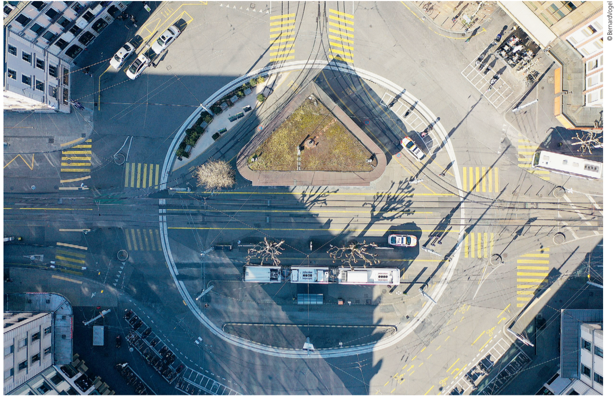
Vue aérienne du rond-point de Rive, où Clé de Rive devait offrir aux Genevois espace et convivialité (votations mars 2021).
