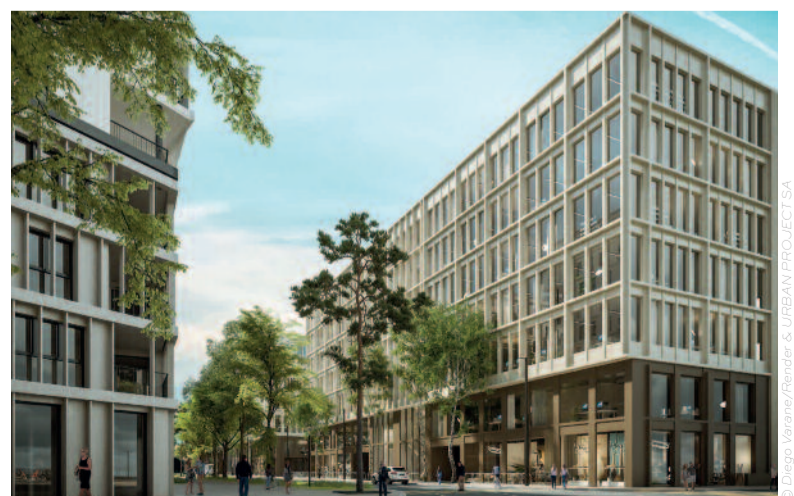
Les Fabriques, modèle de régulation et d'utilisation de l'énergie.
