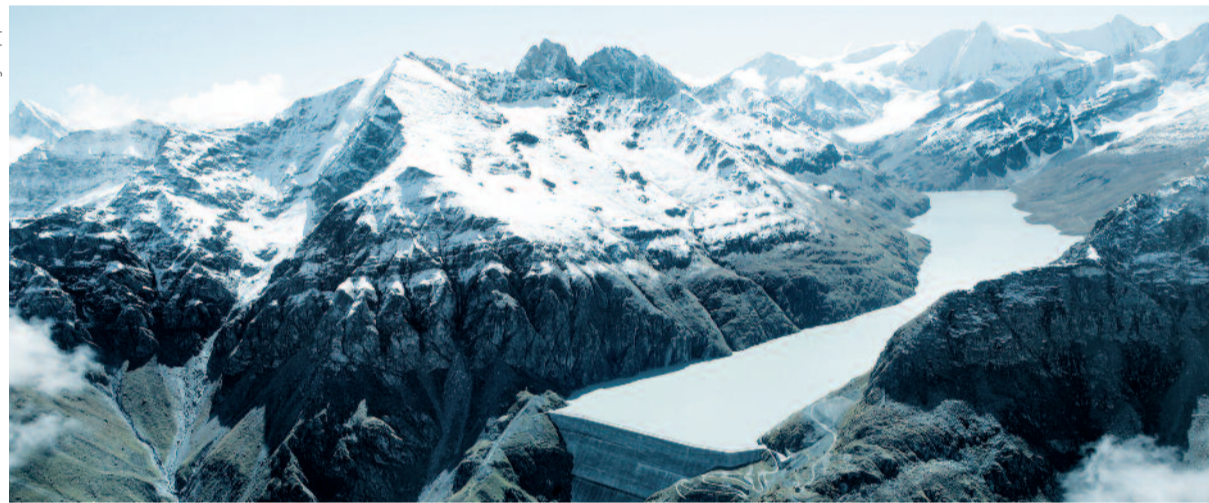
Barrage de la Grande Dixence: un des sites propriété d'Alpiq, leader des fournisseurs d'électricité en Suisse.
