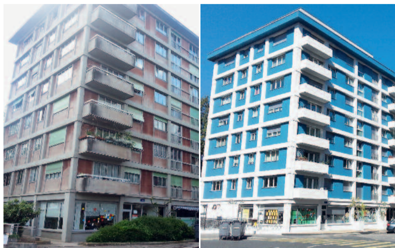
Rénovation de l'immeuble Avenue Dumas à Champel.
