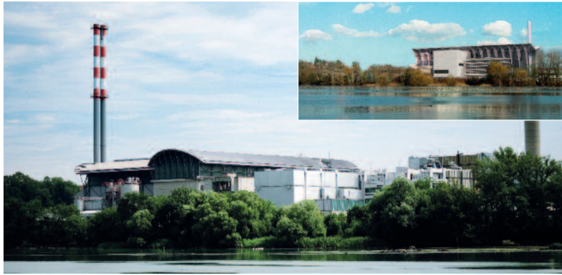
L'usine actuelle et, en incrustation, la future Cheneviers IV.
